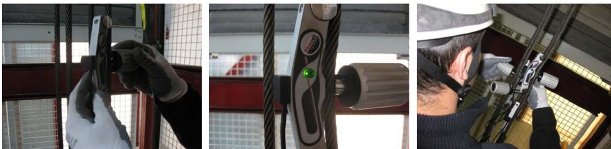
Instalar los sensores RTM en los cables (Cabina ó contrapeso) .El sensor indica mediante un LED su correcta instalación.
